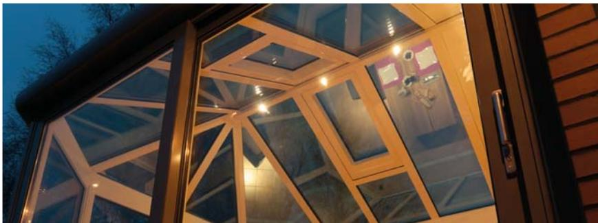
So setzen Sie Ihre Überdachung in das rechte Licht. Mit Beleuchtungspots, die direkt in das Dachprofil integriert sind, kann man sich den eigenen Sternenhimmel zaubern. Die Kabelführung verläuft hier unsichtbar in den Profilen, so dass nichts den unbeschwertem Genuss dieser Illumination stören kann.
